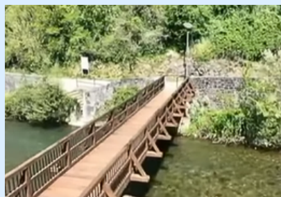
Après la restauration
